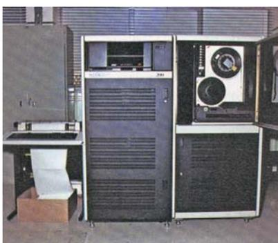
*O sistema Intergraph 200, com a unidade de leitura da banda magnética e uma impressora para a saída dos dados.*
