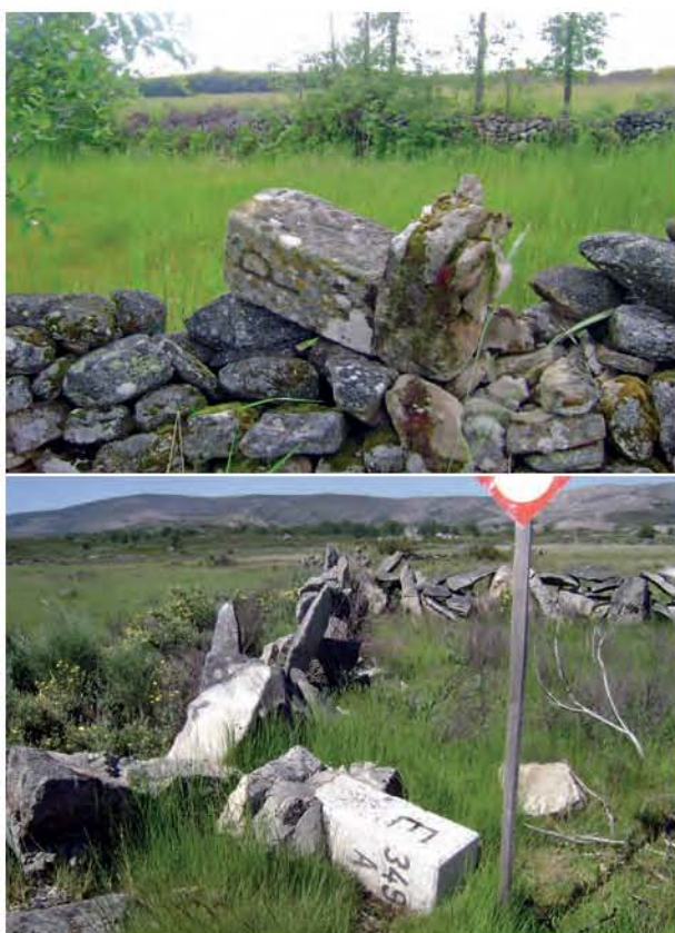
Figura 10 - Marcos de fronteira tombados devido à ruína do muro em que estavam implantados
