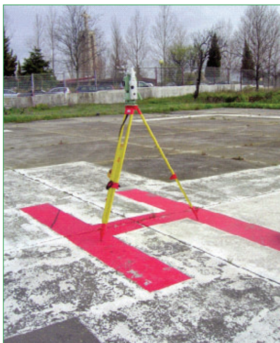
Figura 4 – SmartStation estacionada na TLOF
